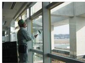
伊達市役所本庁舎・梁川分庁舎 様
